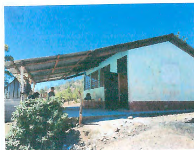
Foto 4: Cerco o muro perimetral
