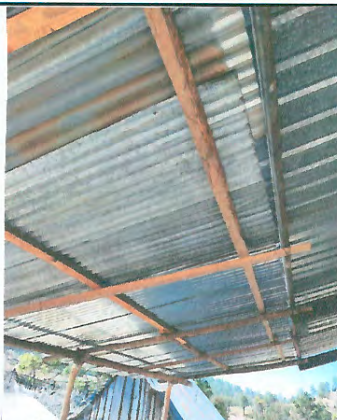
Foto 1: Estructura de techo
